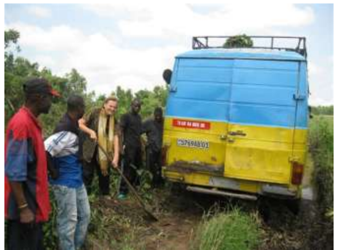
L'égalisation de la route à Mampu
